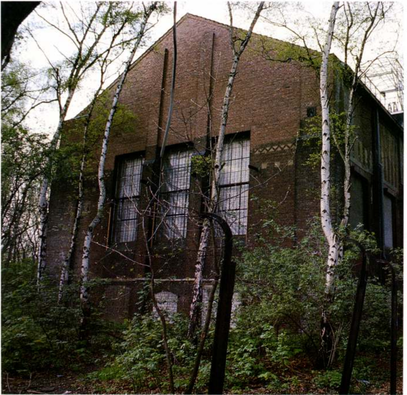
Zechenhalle Teutoburgia, Herne
